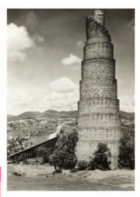
Acueducto de los Remedios, cerca de la Ciudad de México
