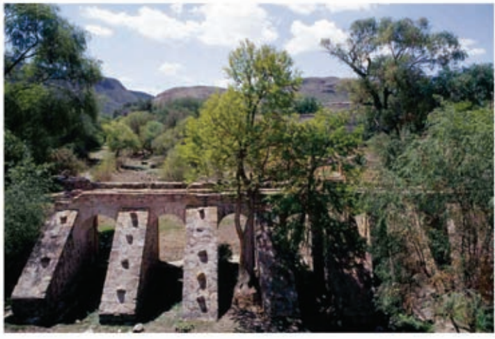
Acueducto de Rincón de Romos, Aguascalientes
