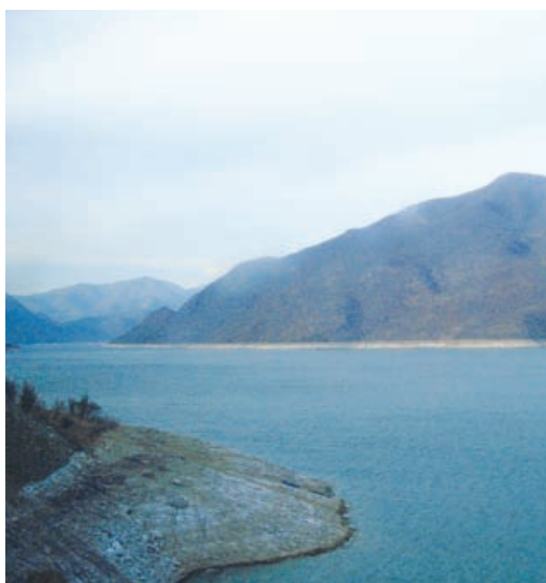
♦ En Chiapas, la presa Belisario Domínguez más conocida como presa La Angostura es la más grande de México por la cantidad de agua que puede almacenar.
